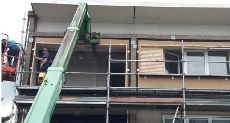
Figure 136 et 137 : Pose des modules.
