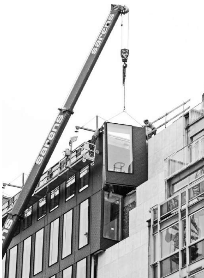
Figure 85 : Pose du dernier module de Loi 227. Source : Architectes Associés, 2018.
