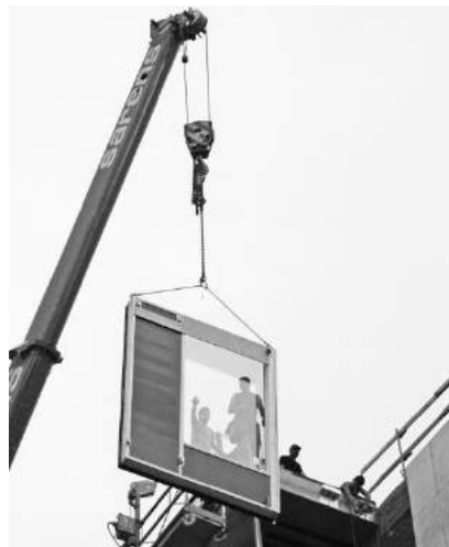
Figure 103 et 104 : Mise en place du module lors du chantier.
