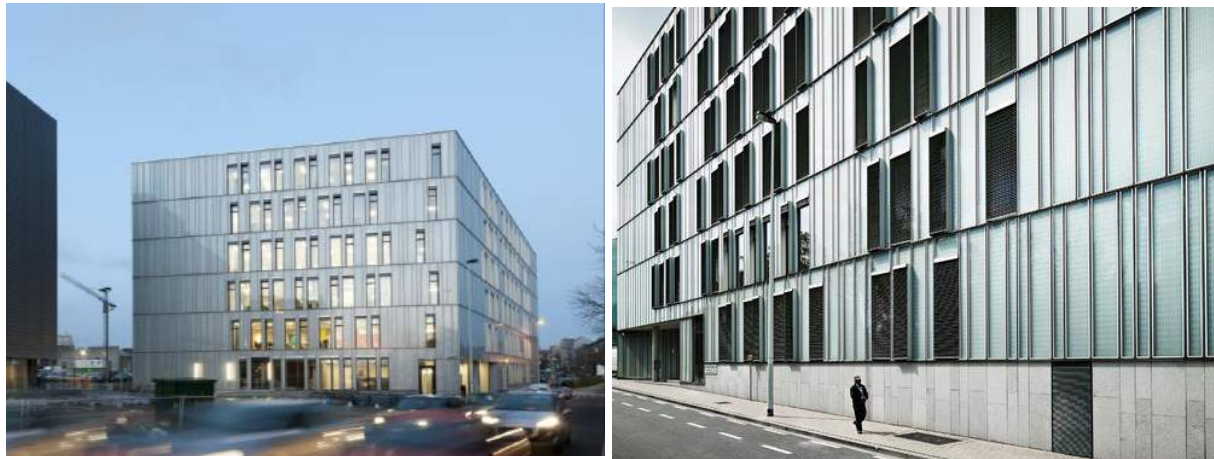
Figure 106 et 107 : façade d'Aéropolis II.
