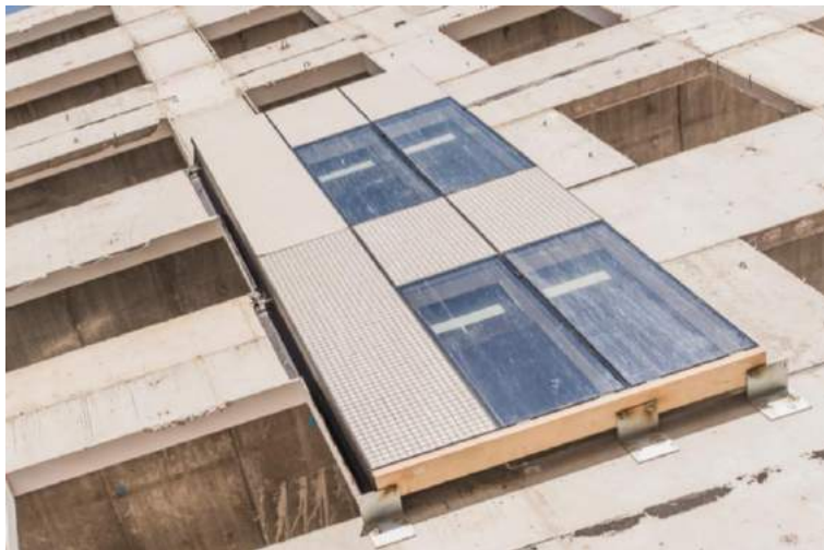
Figure 21: Module de façade pendant le chantier.
