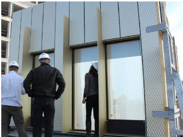
Figure 17 : Modules sur chantier.
