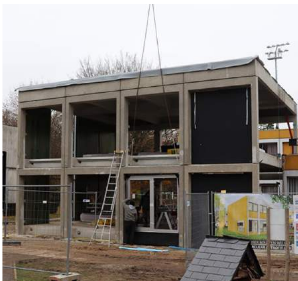
Figure 96 : chantier du projet.
