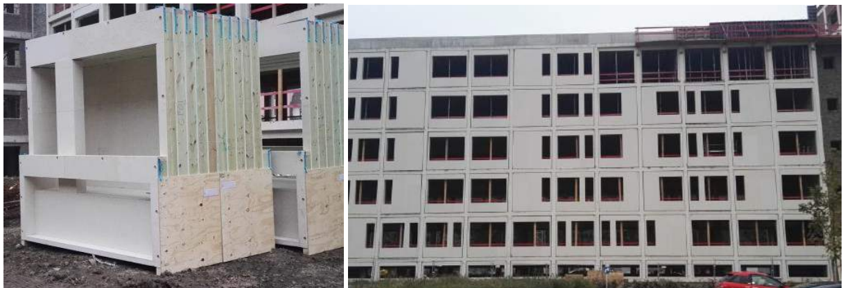
Figure 139 et 140 : Modules à l'arrivée puis sur la structure.
