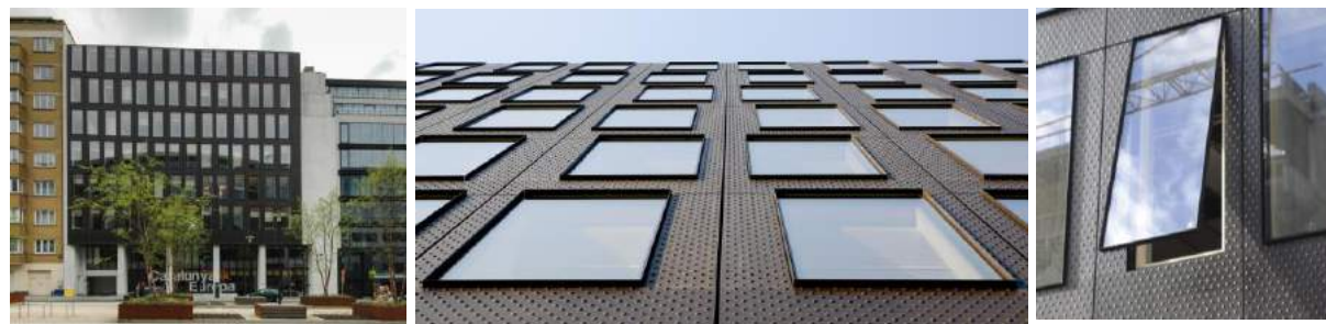
Figure 99, 100, 101 : façade de Loi 227.
