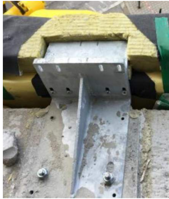
Figure 32: attache d'un module à la dalle.
