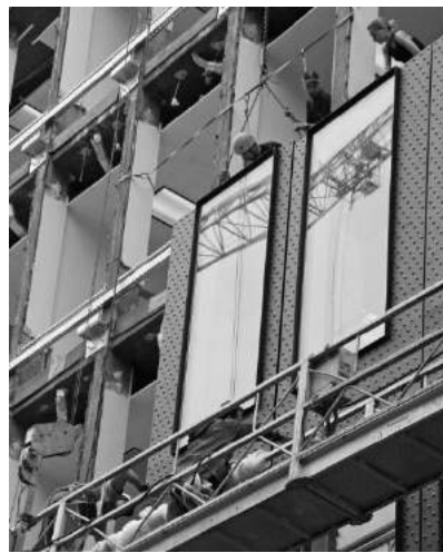
Figure 103 et 104 : Mise en place du module lors du chantier.
