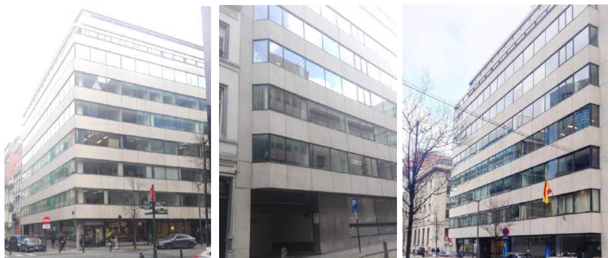
Figure 60 : Bâtiment existant. Source : photos prises par l'auteur.
