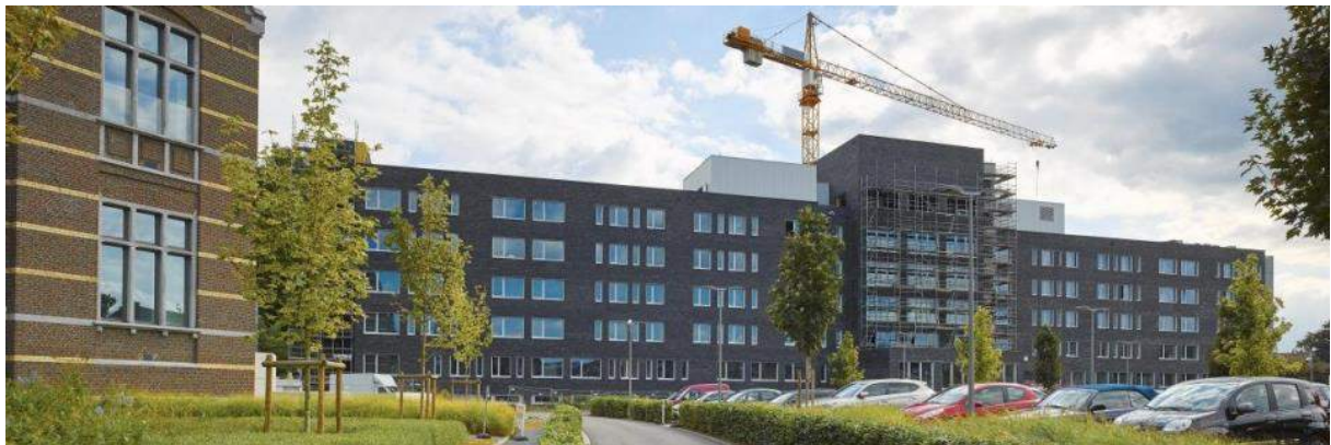
Figure 138 : Bâtiment pendant le chantier.
