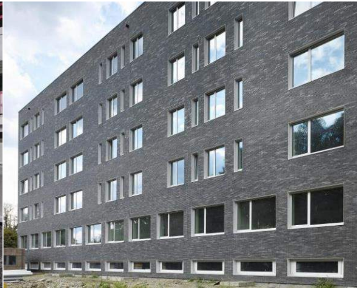
Figure 30 : Façade achevée en briquettes.
