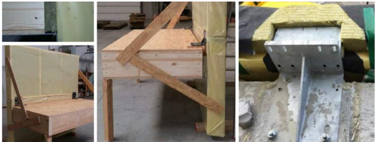
Figure 141 à 145 : Jonctions et attaches des modules à la structure. Source des images : Ateliers de l'Avenir, 2018 et entrevue de Gaëtan Duyckaerts.
