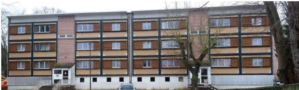
Figure 135 : Bâtiment pendant le chantier avant la pose du revêtement.
