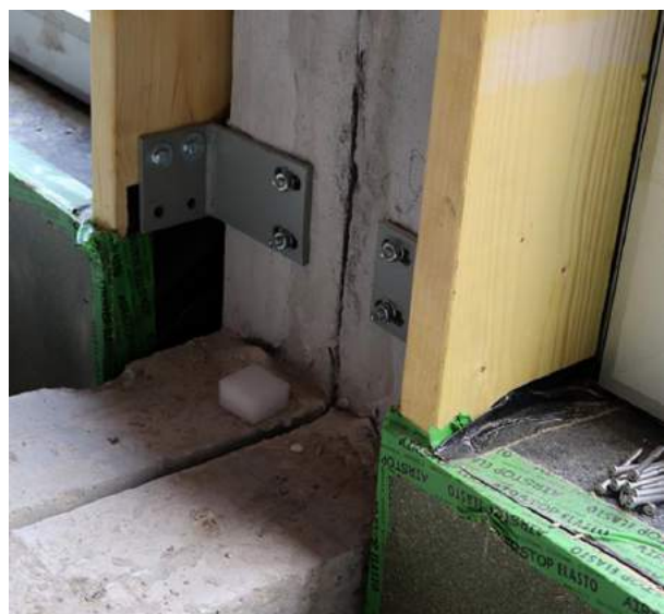
Figure 97 : accroche des modules préfabriqués
