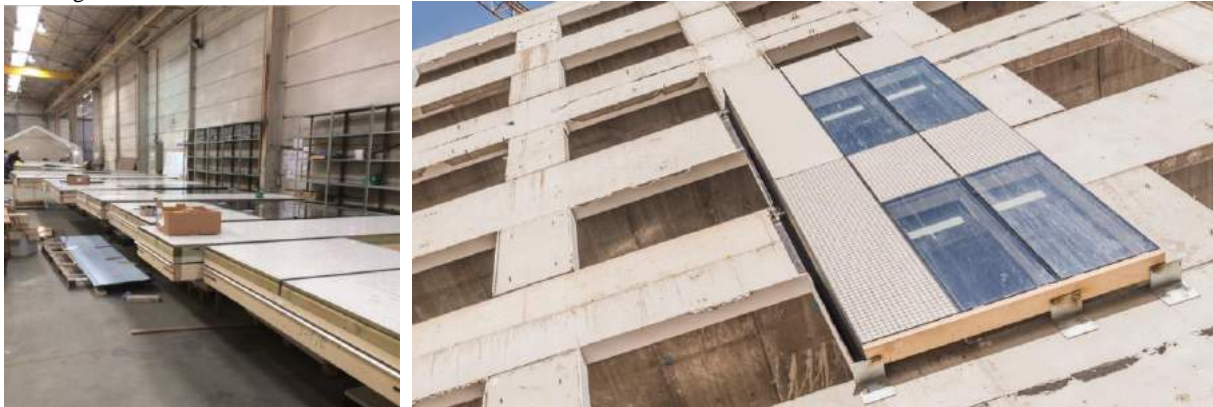
Figures 126 et 127 : Modules en atelier puis sur la façade.
