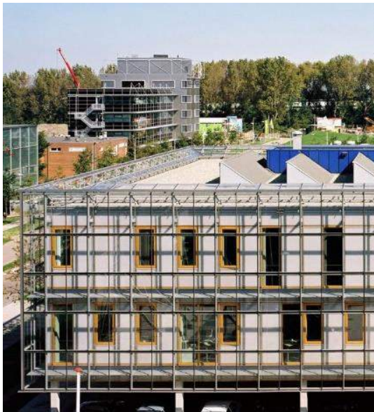
Figure 23 : façade des bureaux
