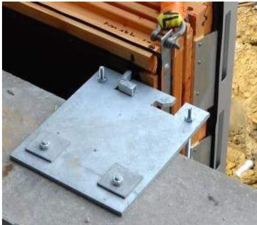
Figure 110 et 111: fixations horizontales en photo et plan.
