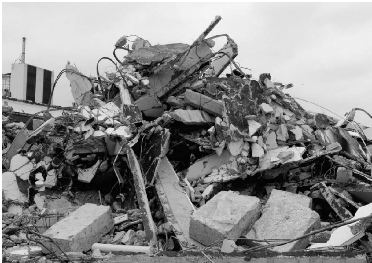
Figure 2 : « Chantier de démolition avec des piles de matériaux recyclables ayant une valeur faible ou nulle en tant que ressources pour les futurs bâtiments. ». Source: Guldager, Sommer, 2016.
