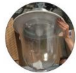
Luminaires de voirie Dépose de l'éclairage urbain
