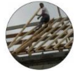
Chevrans pin Douglas Stock entreprise de charpente
