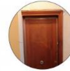
Portes palières en chêne Réhabilitation d'un immeuble de logement de Paris-Habitat
